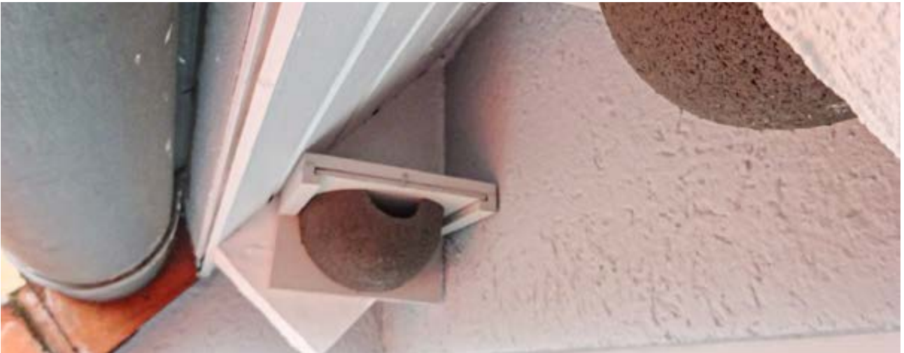
Im Handel verfügbare Nisthilfen für Mehlschwalben. Um Verschmutzungen an der Fassade zu vermeiden, sind diese Nisthilfen an den Dachsparren montiert.
