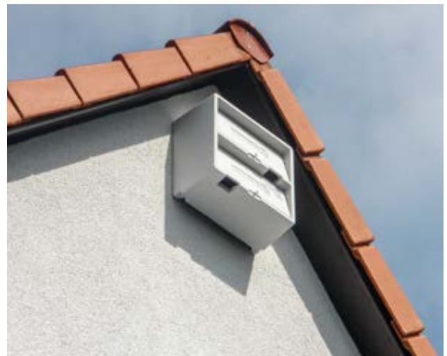
Ein im Handel zu beziehender Nistkasten mit zwei Brutkammern für Mauersegler, der auf die Fassade montiert wird. Die Rückwand ist nach innen versetzt und bietet so zusätzlich Fledermäusen ein Spaltenquartier zwischen Hauswand und Nistkasten.
